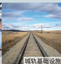
城轨基础设施
